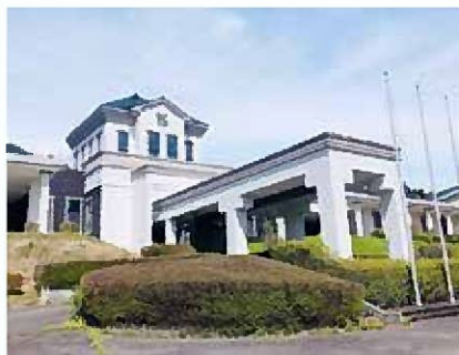
改修工事を終えた本部棟
